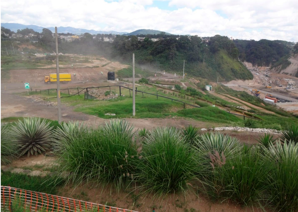
Perspectiva del sitio de disposición final. Ampliación norte del vertedero de la zona 3. Fotografía de Cristhians Castillo Folgar.
